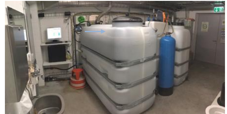
Beispiel Urinaufbereitungsanlage an der Eawag: eine Zentrale Anlage verarbeitet Urin von 500 Personen zum Flüssigdünger Aurin.
